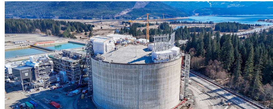
LNG CANADA EXPORT FACILITY // KITIMAT, B.C., CANADA
