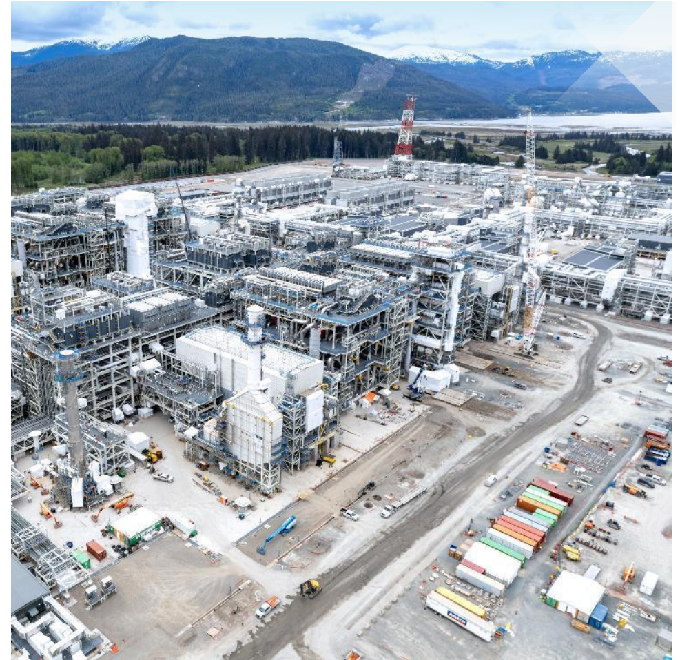
LNG CANADA EXPORT FACILITY // KITIMAT, B.C., CANADA
