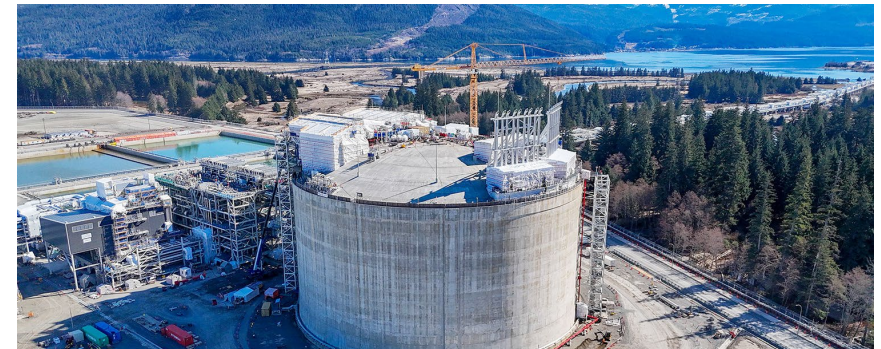
LNG CANADA EXPORT FACILITY // KITIMAT, B.C., CANADA
