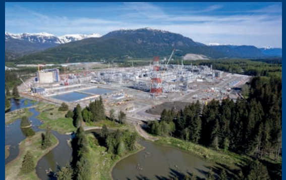
LNG Canada Export Facility // Kitimat, B.C., Canada
